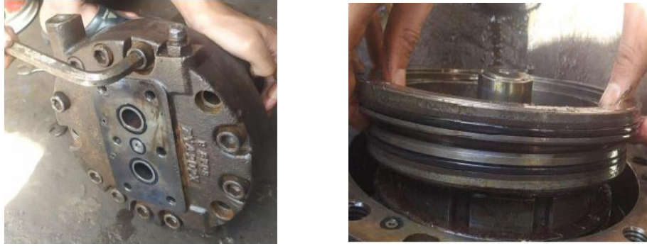
Gambar 3. Proses pembongkaran travel motor
